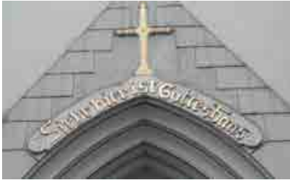
„Siehe, hier ist Gottes Haus“ – Aufschrift über der Kirchentüre
