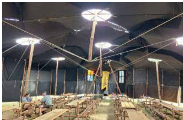
Die fertige Halle mit ihren 2 fliegenden Mittelstützen
